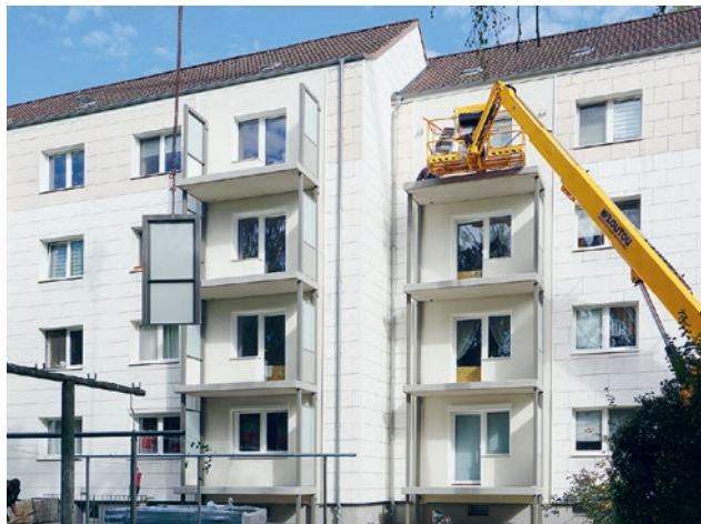
Balkonanbau Goethestraße 8 - 18 a
